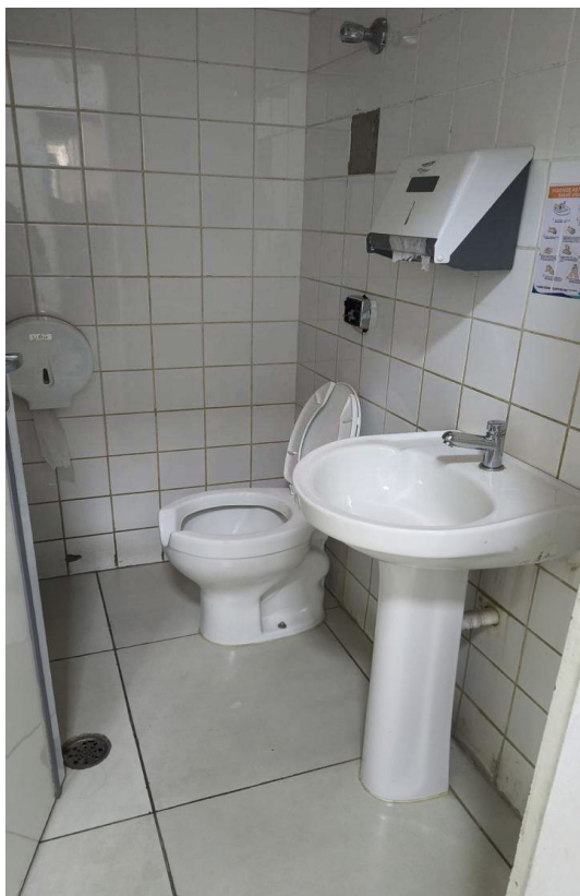
REVITALIZAÇÃO DO BANHEIRO DO CORREDOR
