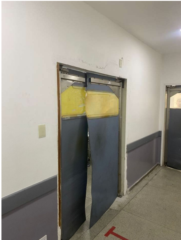
AMPLIAÇÃO PORTA DA EMERGÊNCIA
